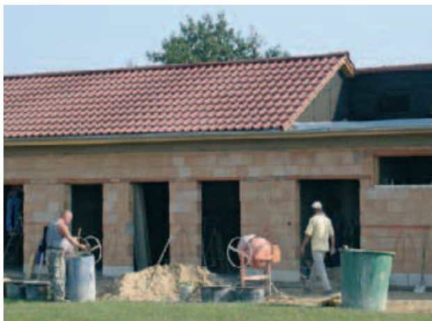
▲ Ein neues Projekt. Bau von acht Wohnungen in einem ehemaligen Schuppen
